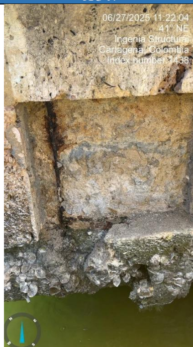
Imagen 211. Registro de recubrimiento cara lateral
