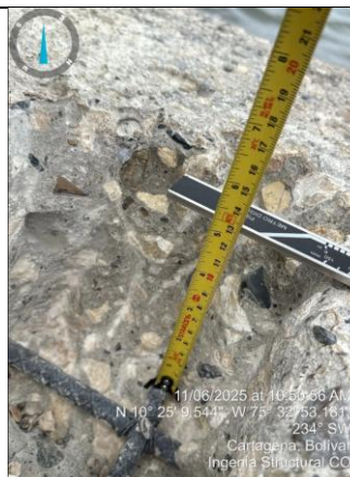
Imagen 196. Registro de recubrimiento cara superior
