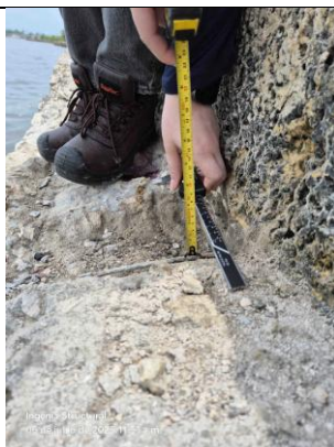
Imagen 156. Registro de recubrimiento cara superior
