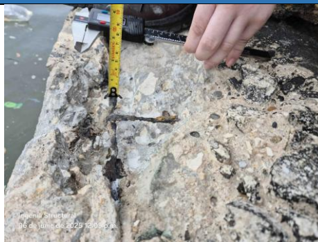
Imagen 162. Registro de recubrimiento cara superior
