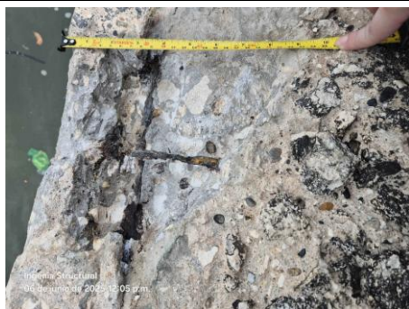
Imagen 161. Registro de recubrimiento cara lateral
