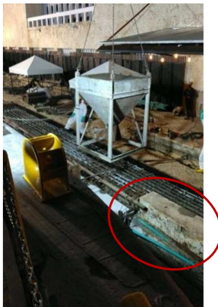
Imagen 18. Zona con tablestacado en sector 2 y viga cabezal con concreto antiguo
