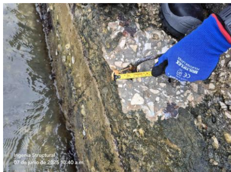
Imagen 172. Registro de recubrimiento cara lateral 45-V-CL
