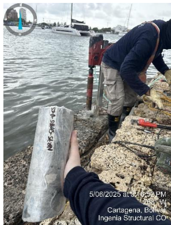
Imagen 28. Extracción de núcleos en cara superior de la viga, sector 7
