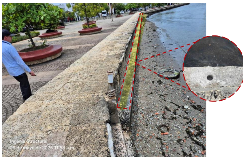
Figura 159. Zona intervenida con mortero en sector 6
