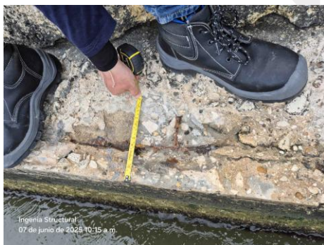
Imagen 159. Registro de recubrimiento cara lateral
