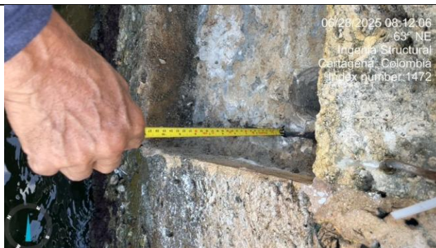
Imagen 210. Registro de recubrimiento cara lateral
