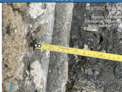
Imagen 215. Registro de recubrimiento cara lateral
