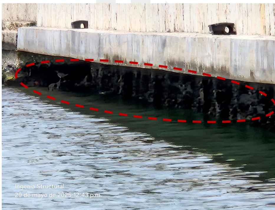
Imagen 306. Tablestacado instalado en sector 2-a fecha 2025
