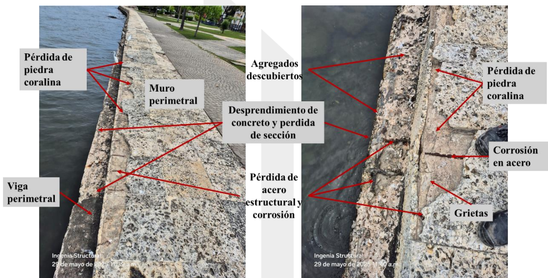
Imagen 4. Inspección visual en sector 6
