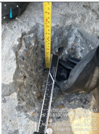
Imagen 222. Registro de recubrimiento cara superior
