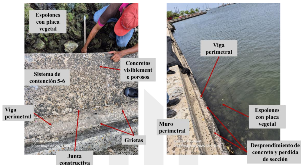
Imagen 9. Inspección visual en sector 5
